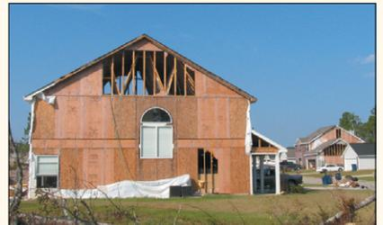
Este barrio experimentó una significativa pérdida de recubrimiento de vinil. Sin embargo, las casas completamente revestidas estructuralmente sólidas.
