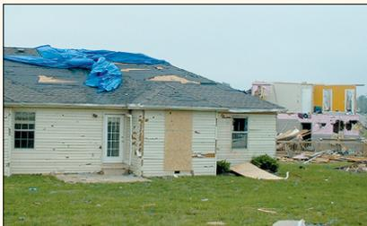
Los sistemas de muro no estructurales de esta casa de dos pisos ofrecieron muy poca resistencia al daño por objetos volantes y las fuerzas laterales.
