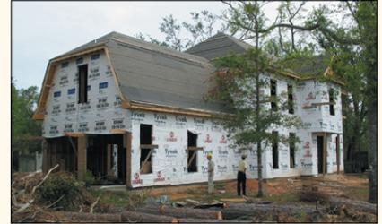
Note que el recubrimiento de vinil en el área de la cochera quedó intacto al estar esa parte de la casa forrada con paneles estructurales de madera, y que ya no existe ese recubrimiento de vinil en las áreas donde se utilizó revestimiento de espuma.
