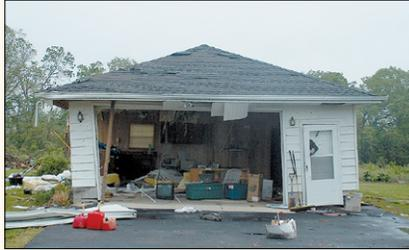
Los revestimientos para muros de OSB se comportaron mucho mejor bajo el recubrimiento ligero de vinil comparado con los materiales de revestimiento no estructural para muros mostrados aquí.
