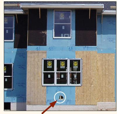
Algunos materiales para muros, tales como el revestimiento de espuma mostrado en la foto de arriba, son susceptibles a daño en la obra. Cuando se perforan agujeros en el tablero durante la construcción, cualquier beneficio de conservación de energía proporcionado por el revestimiento de espuma aislante es nulificado por el aire que se infiltra.
