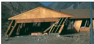
lados de una casa—resultan de la fuerza del viento o de los terremotos. Los muros con mejores arriostamientos tienen menos probabilidad de deformarse, sufrir daños o colapsarse durante vientos de gran intensidad o un sismo.
