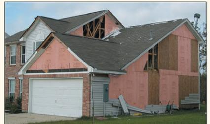
Esta casa estaba en el mismo barrio que la casa en la foto de arriba. El revestimiento de espuma fue inadecuado para resistir las presiones del viento en los muros frontales. Aquí ocurrió infiltración masiva de agua lo que resultó en daño a la casa y sus contenidos.
