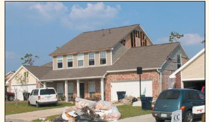
Los revestimientos de espuma y de vinil se perdieron en la parte superior de los muros extremos en Sunkist (Biloxi), Mississippi, justo al sur de la carretera I-10. Aquí ocurrió infiltración masiva de agua lo que resultó en daño a la casa y sus contenidos.
