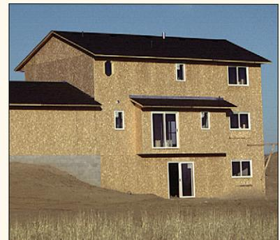
Los recubrimientos con paneles estructurales de madera mostrados en la foto de arriba, proveen una conexión perfectamente ajustada al material del entramado y es fuerte y resistente a las perforaciones accidentales. En suma, los tableros de revestimiento de Madera contrachapada y de OSB proveen al propietario de la vivienda con una casa resistente y libre de fugas de energía.
