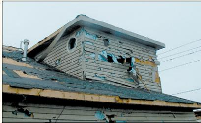
El revestimiento de madera contrachapada de bajo del recubrimiento de vinil severamente dañado permaneció intacto en este muro.
