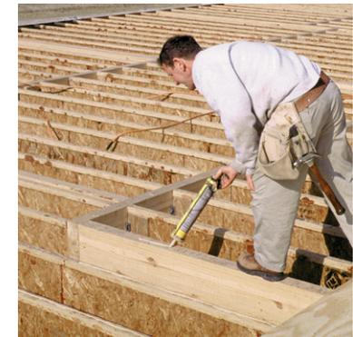
Las vigas-I representan una alternativa de alto desempeño a las vigas de madera aserrada para aplicaciones en pisos residenciales y construcción comercial ligera.
