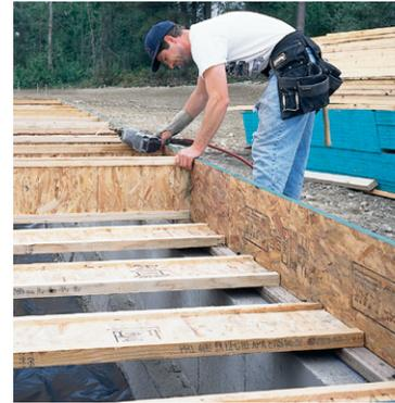
Un tablero de borde de OSB típico se apoya totalmente en la solera de desplante y es clavada por la cara en el extremo del patín de la viga-I y clavada con clavos lanceros a la solera de umbral.
