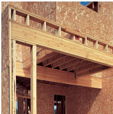
La madera laminada tiene mayor resistencia y rigidez que la madera aserrada de dimensiones comparables y, libra por libra, es más resistente que el acero.
