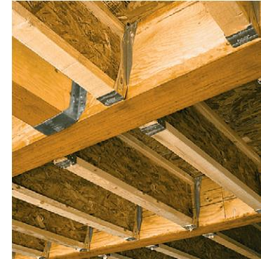
Madera LVL altamente predecible y uniforme se usa como una viga del piso.
