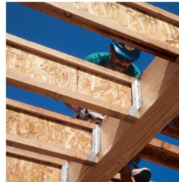
Con un desempeño consistente, las vigas-I se fabrican en peraltes específicos comúnmente usados en construcción residencial.
